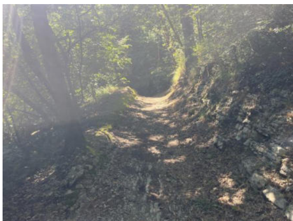
FOTO 3: CARREGGIATA RIDOTTA SCARPATE IN ROCCIA
